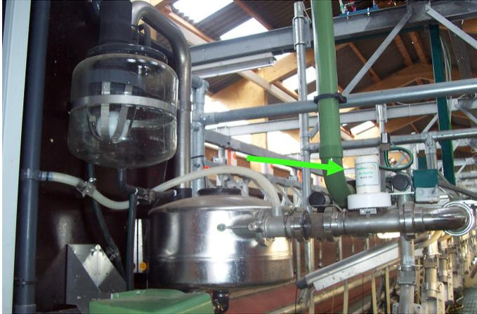
Bild 2: Injektoren sorgen durch Einströmen atmosphärischer Luft für die notwendige Turbulenz im Milchleitungssystem.
