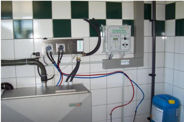
Bild 1: Reinigungsautomaten übernehmen die Steuerung der einzelnen Reinigungsphasen
