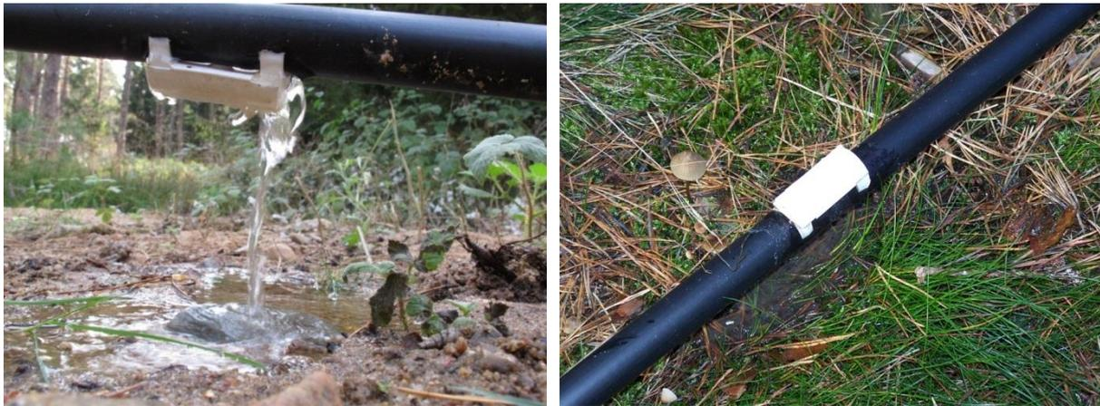
Abb. 3-6: Versickerungsdüsen mit Schutzkappe
