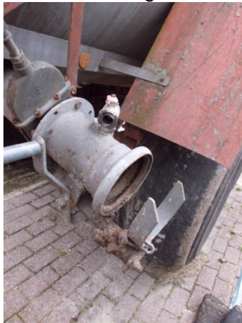
Bild 1 Mit dieser Bypassleitung kann man EM gut „zudosieren“
