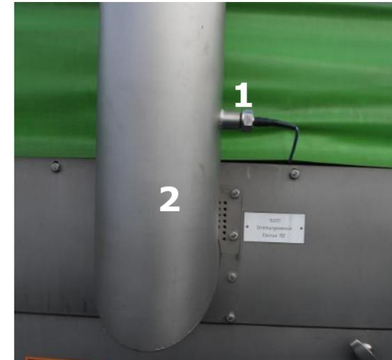
Bild: Strömungssensor (1) zur Überwachung der Abblaseeinrichtung einer Überdruck-sicherung (2) (Bildquelle: Wiese)
