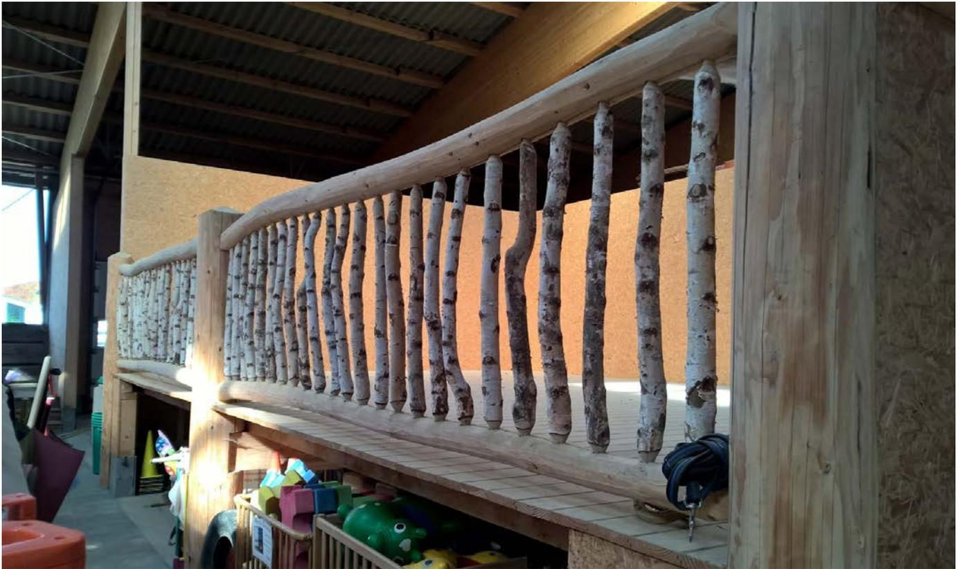
Abb. 3.26. „Naturnahes“ Geländer aus heimischem Birkenrundholz in einer Reithalle in Langenrehm.
