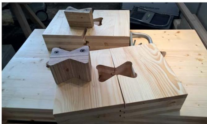
Abb. 4.17. Neue Holzbaustoffe wie Brettsperrholz und neue Verbindungsmittel dafür eröffnen neue bautechnische Möglichkeiten und erfordern eine entsprechende Weiterbildung!
