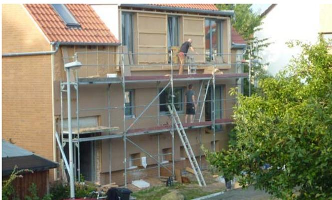
Abb. 4.16. Energetische Sanierung und Dachgeschossausbau mit Holz.
