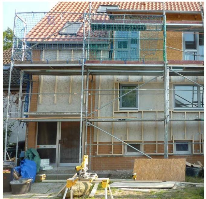
Abb.3.24. Ausbau einer Gaube und Fassadendämmung mit Holz.
