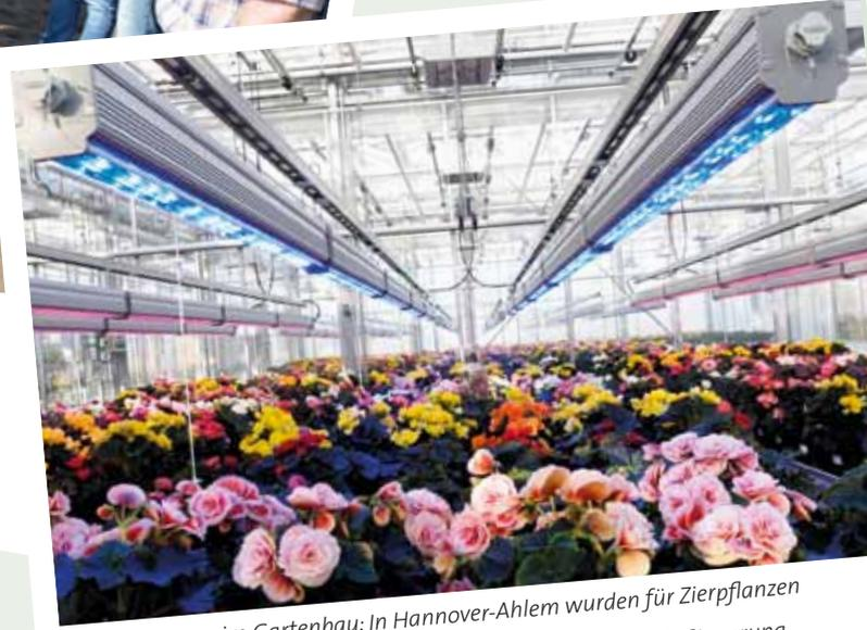
Versuchswesen im Gartenbau: In Hannover-Ahlem wurden für Zierpflanzen leistungsstarke LED entwickelt. Durch deren Leuchtkraft ist die Steuerung des Wachstums von Zierpflanzen gezielt möglich.
