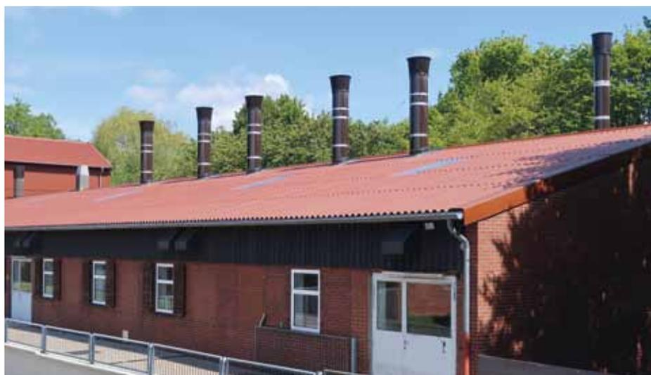
werden nach jeder Futterumstellung und nach vorgegebener Mastzeit gewogen. Das Lüftungssystem wurde an jedes Abteil angepasst. Es bildet die Grundlage für die genaue Schadgasmessung pro Abteil. Im Abteil sind Ammoniak-, Kohlenstoffdioxid-, Luftfeuchte- und Temperatursensoren eingebaut.
