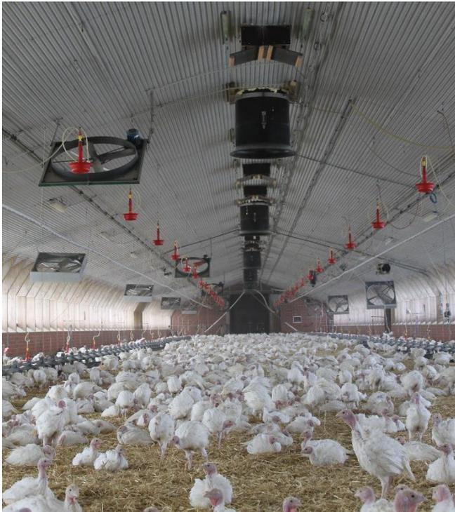
Abbildung 56: Umgebauter Putenmaststall mit Zuluftventilatoren (rund) und Abluftschächten mit je zwei regulierbaren Flügelklappen.
