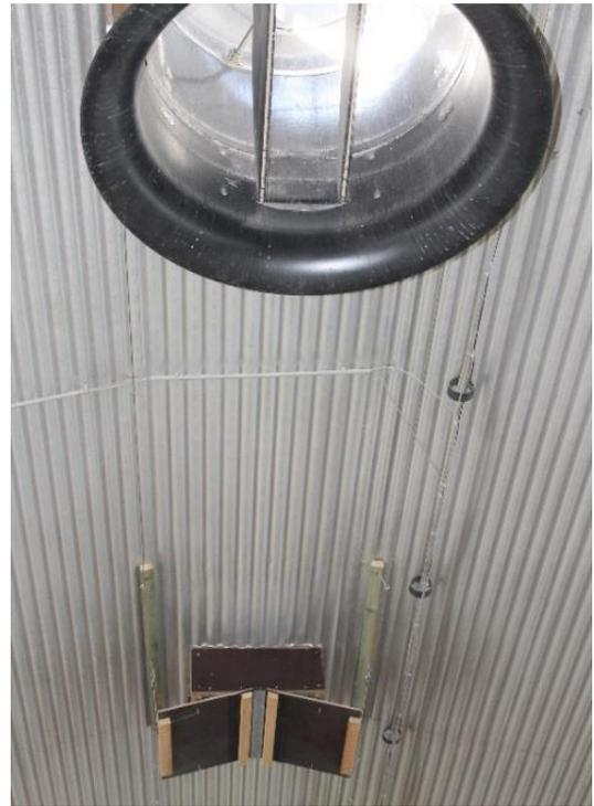
Abbildung 57: Zuluftschacht mit Ventilator und geöffneten Zuluftklappen (oben) und Abluftschacht mit Flügelklappen (unten)
